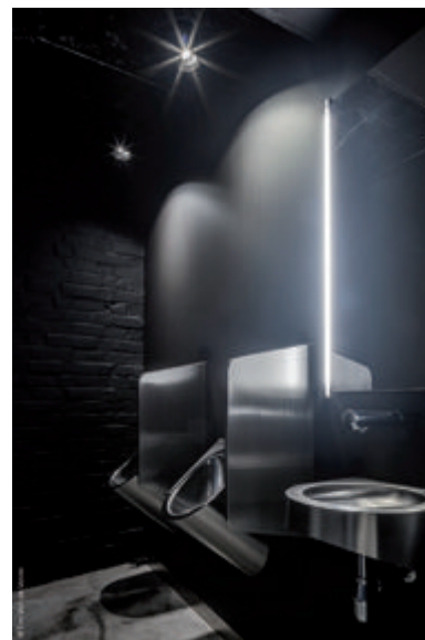
Waschtisch PMR XS aus Edelstahl Werkstoff 1.4301 satiniert / Art. DELABIE: 120400 TEMPOMATIC 4 für Waschtisch, Wandmontage Art. DELABIE: 443506 Badspiegel aus Edelstahl / Art. DELABIE: 3459 Urinal DELTA wandhängend aus Edelstahl Werkstoff 1.4301 doppeltes Materialfinish / Art. DELABIE: 134772 Urinal-Schamwand LISO wandhängend aus Edelstahl Werkstoff 1.4301 satiniert / Art. DELABIE: 100590
