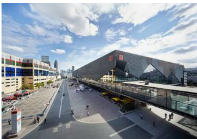
Die Messe Frankfurt, seit Kurzem mit DELABIE Produkten ausgestattet
